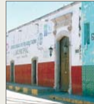
Aspecto de la arquitectura del centro. La Unidad Básica de Rehabilitación, que aún conserva su esencia original.
