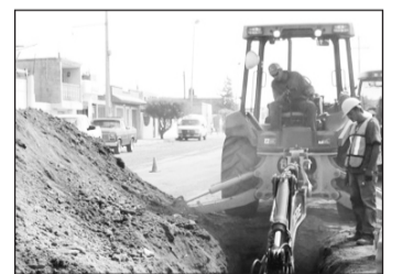
Aplican Programa de Agua, Alcantarillado y Saneamiento.
