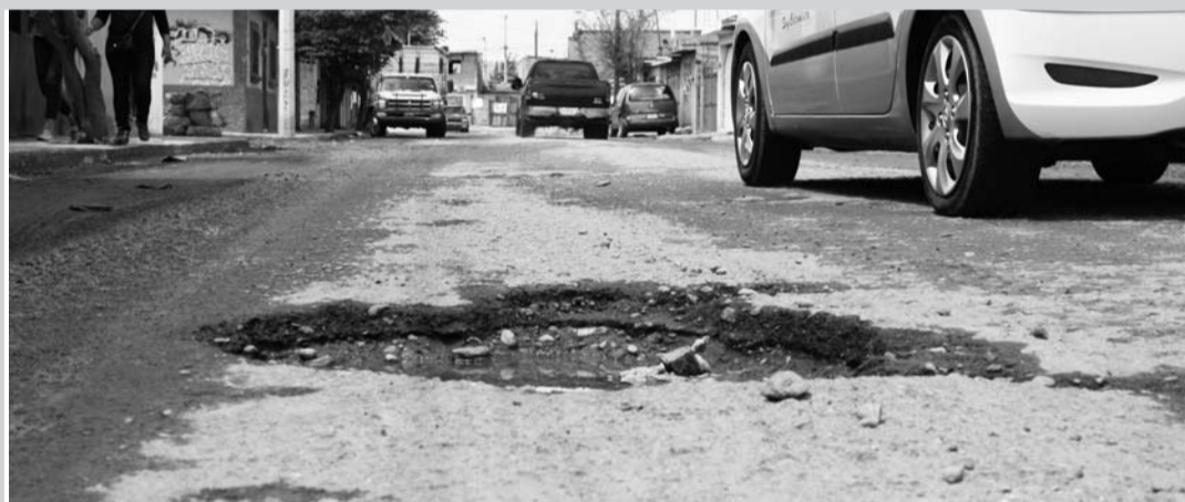
Existen algunos baches "ponchallantas": su profundidad y forma, provoca que los neumáticos resulten frecuentemente dañados.
