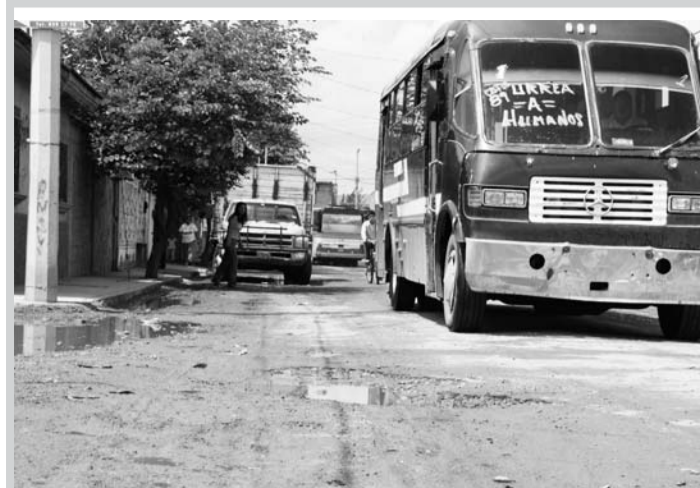
El paso de camiones pesados también incide en el rápido desgaste del pavimento.
