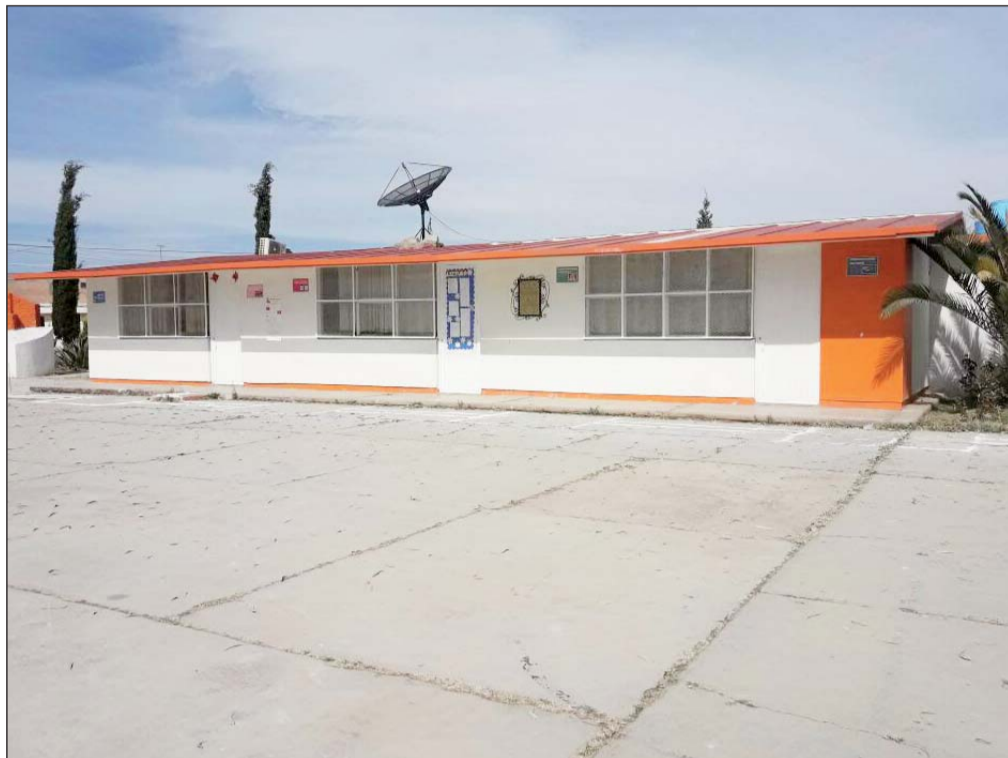
Oportunidad. Aprovechando que las escuelas se quedan vacías en las temporadas vacacionales, los ladrones las “visitan” y hacen de las suyas para sustraer los equipos más valiosos.
