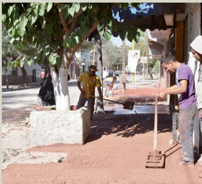
Ante la problemática, ayuntamientos como el de Lerdo habilitan las rampas que se requieren en la ciudad.
