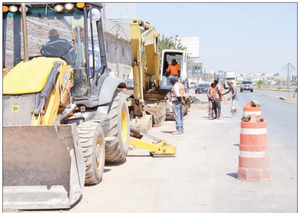
Obra. Los fenómenos que se han presentado en los últimos meses obligan a los gobiernos a tomar cartas en el asunto en materia de prevención de desastres.
