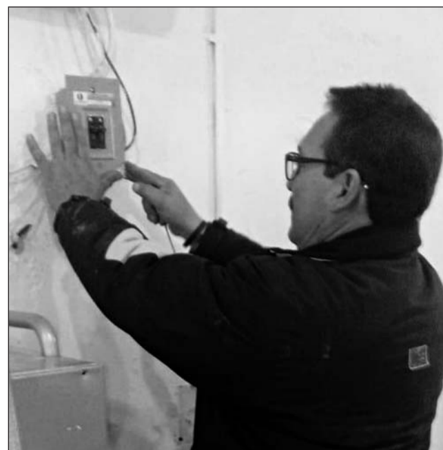
Acciones. Entre las mejoras, se encuentra la sustitución de luminarias y del cableado eléctrico.
