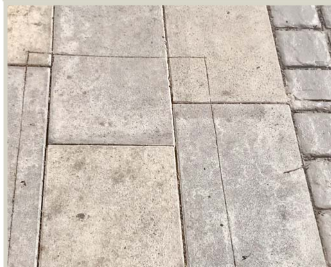
Algunas partes de la zona adoquinada han sido marcadas, señal de que serán cortadas para otros trabajos.
