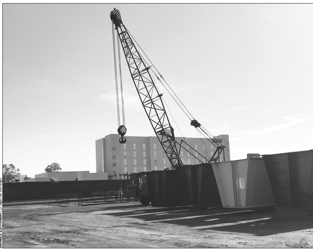
Avance. Se espera comenzar a colocar estructuras en diciembre próximo en algunos carriles, buscando causar el menor caos vehicular posible.
