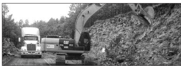
Apoyo. Cuadrillas en alerta para dar respuesta inmediata en vías de comunicación afectadas.
