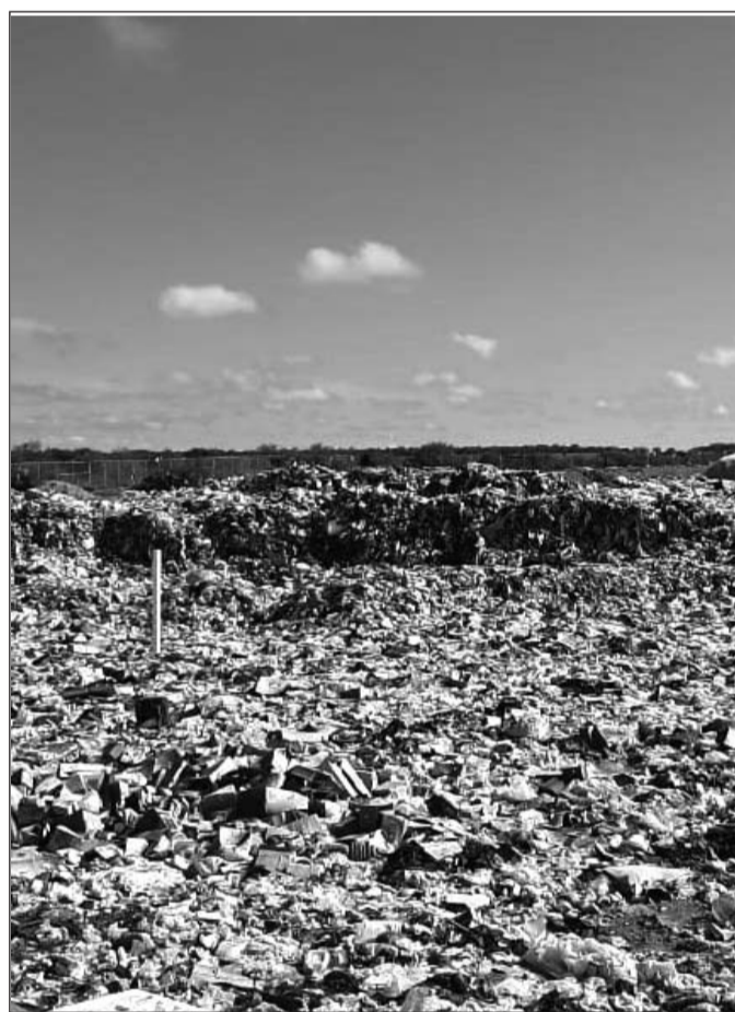
Rellenos. Cinco rellenos sanitarios del estado están bajo procedimiento por incumplimiento de algunas normas.
