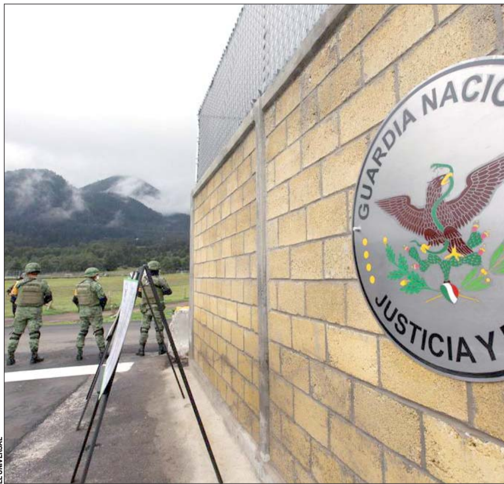
Instalaciones. Un nuevo centro de operaciones se construyó en el Ajusco, en la alcaldía Tlalpan.
