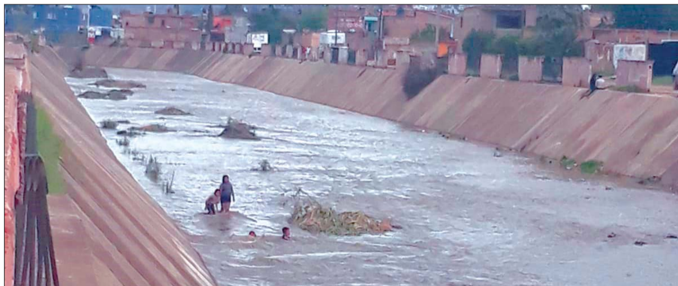
Se han captado niños jugando dentro del Arroyo Seco, así como en el canal de desagüe de la presa del Hielo.
