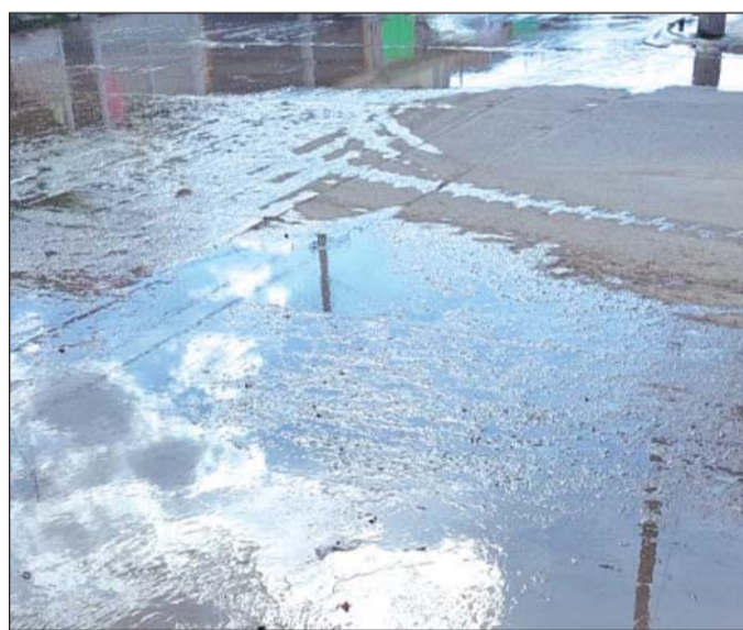
Afectación. Trabajadores de la empresa de distribución de gas subterráneo, causaron daños a una línea de agua potable.
